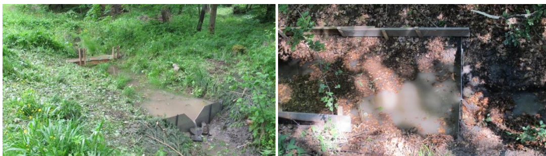
Obrázek č. 14 a 15: Plné instalace měřící aparatury na závěrných profilech recipientů v mikropovodí Křtiny (vlevo) a Útěchov (vpravo) Studie je realizována formou srovnávací analýzy průtoků (resp. trendů jejich průměrných denních hodnot)
